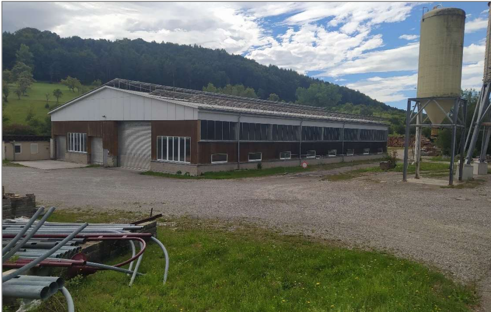
Abb. 1: Plangebiet mit Bestandsgebäude; Blick nach S (Foto: HPC AG, 03.09.2025)
